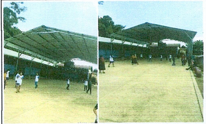
Foto 2: mejoramiento de pórtico con lámina calibre 26
