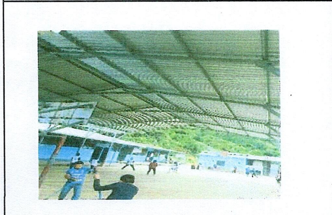
Foto 3: mejoramiento pórtico con lámina calibre 26
