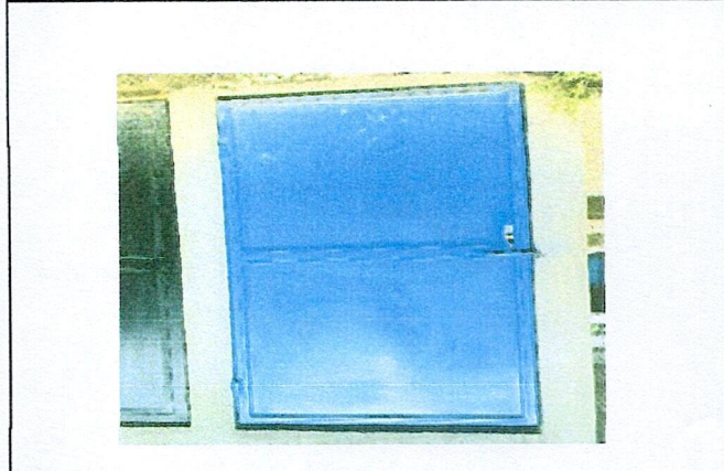
Foto 4: mejoramiento de puerta
